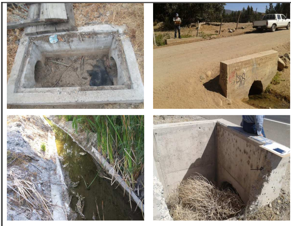
Figura 6-3. Obras de conducción
