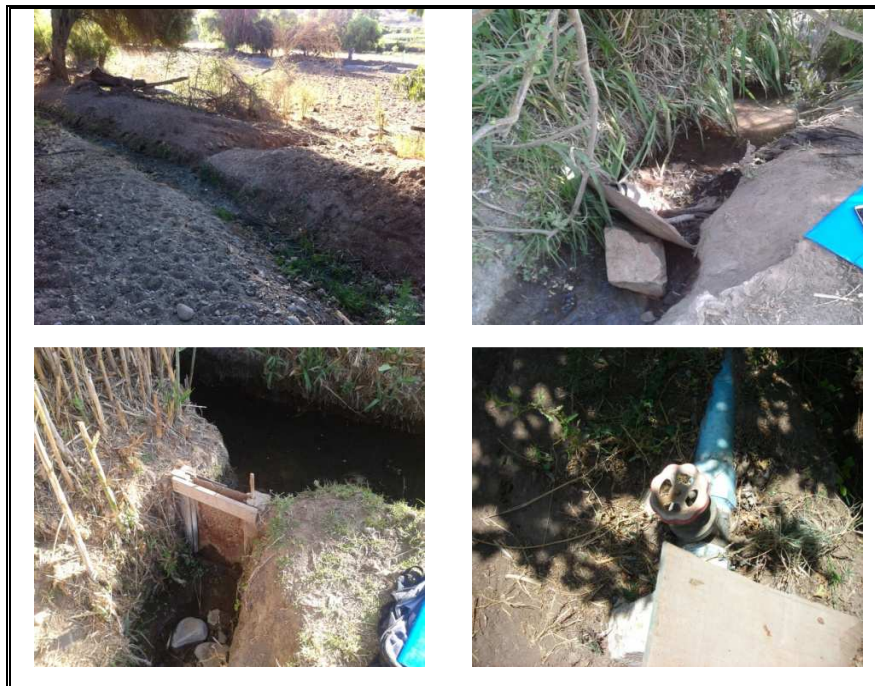
Figura 6-2. Estado general de las obras
